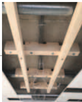
Unterkonstruktion für eine Decken-T-Schiene.
