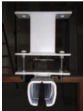
Einbausituation bei einer abgehängten Decke mit vorab montiertem Stahlträger.
